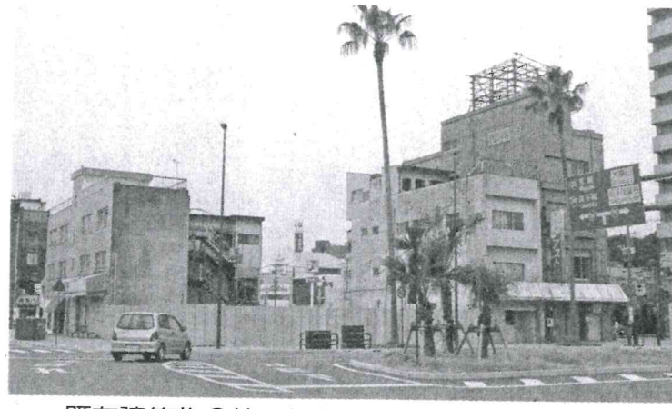
既存建築物2棟の解体が終わった延岡駅前再開発ビルの建設予定地
