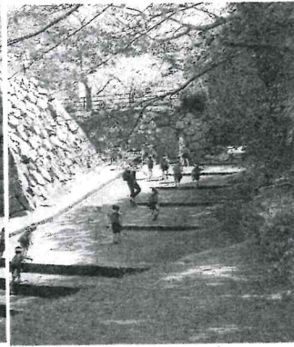
入口を曲がりくねりて防衛効果を高めた、折形と呼ばれる構造が見られる二階門構
