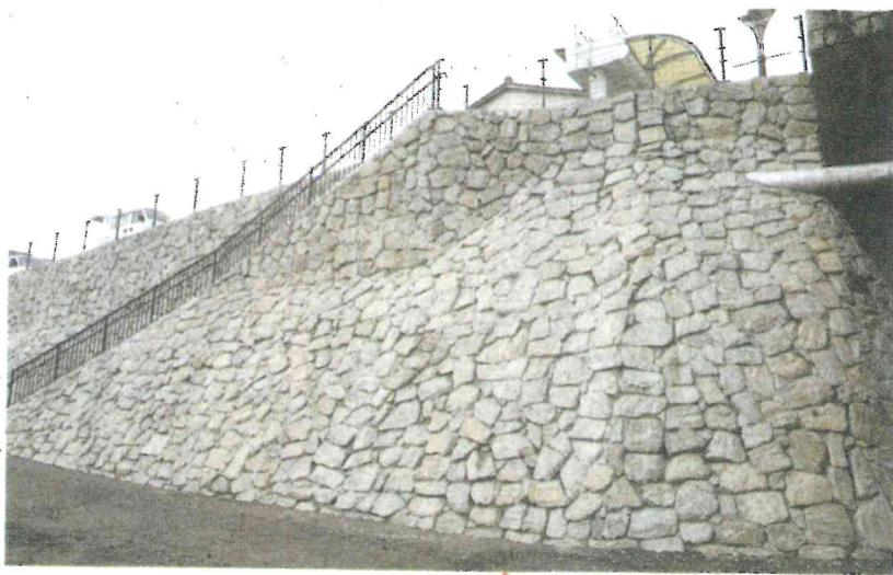
城山の石垣風に施工された板田橋—五ヶ瀬橋間の五ヶ瀬川右岸堤防護岸。補修に合わせて畠堤を川側に移動
