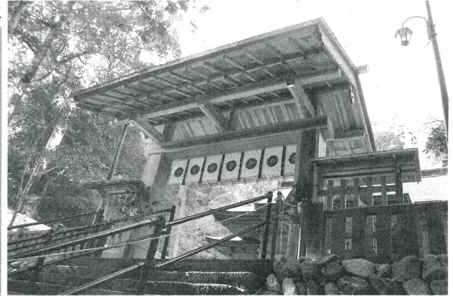
新たに建設された御神門
