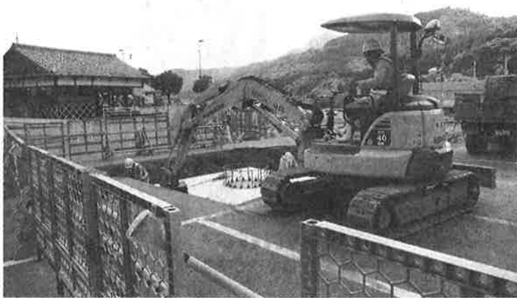
駐車場とはゆまを結ぶ歩道橋の基礎工事が始まる
