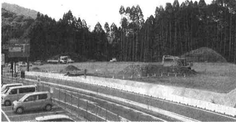
掘削工事が終了した新駐車場。手前の道路は北川ICと国道10号を結ぶランプウエー
