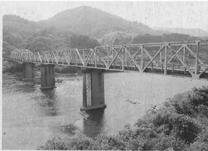
架け替えられる現在の川水流橋
